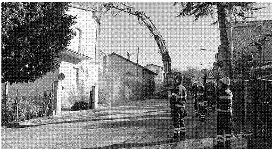
INTERVENTI URGENTI La demolizione di uno degli edifici più danneggiati dalle scosse
